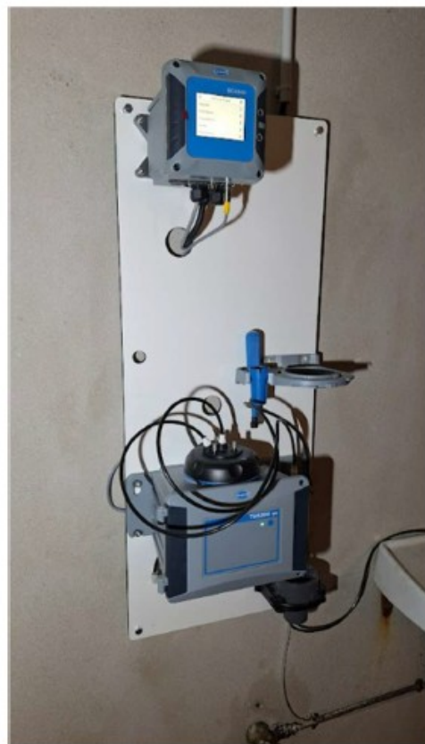
Installation de turbidimètres en ligne aux stations de production d'Ay-Mareuil et de Tauxières-Mutry
