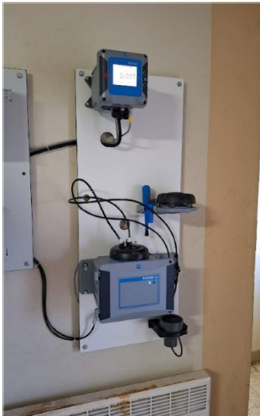
Installation de turbidimètres en ligne aux stations de production d'Ay-Mareuil et de Tauxières-Mutry
