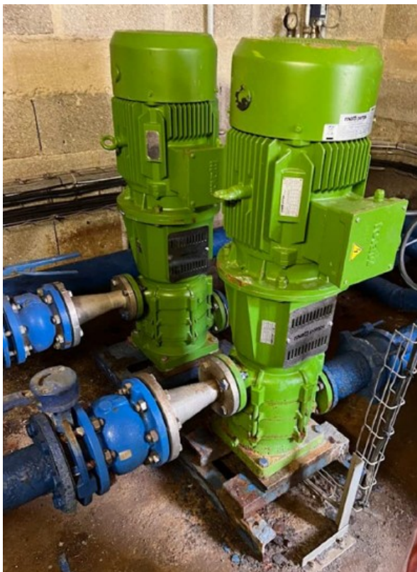
Station de reprise d'Hautvillers : Renouvellement Pompe de reprise n°1
