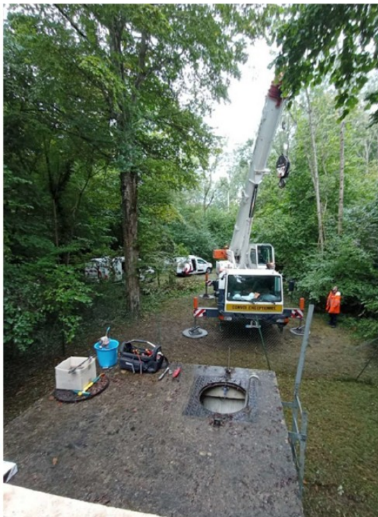
Champ captant Bisseuil : Renouvellement pompe de forage n°3 (puit n°1)
