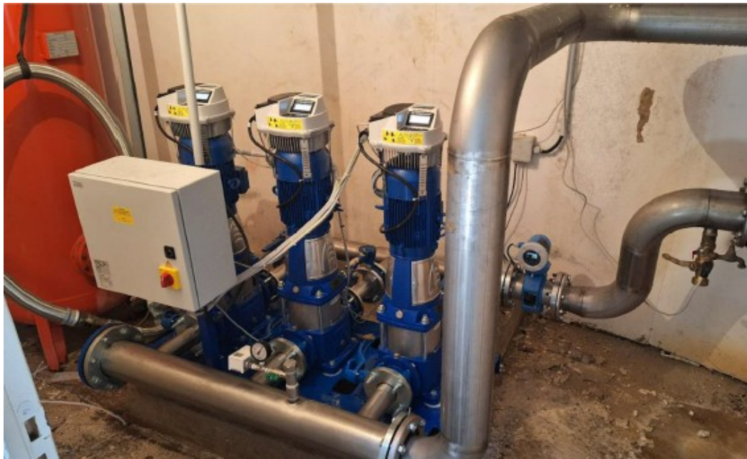
Réservoir de Bouzy Remplacement complet de la surpression
