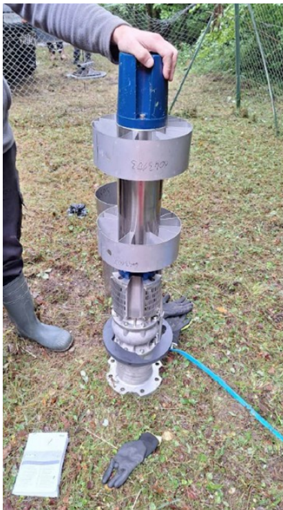
Champ captant Bisseuil : Renouvellement pompe de forage n°3 (puit n°1)
