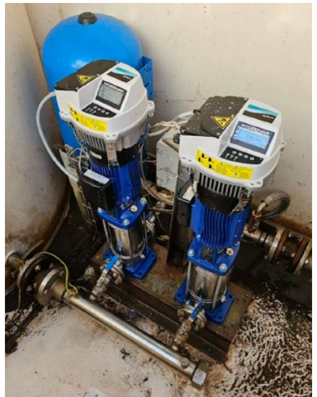
Station de surpression de Germaine Ferme aux Bœufs 2 pompes de surpression
