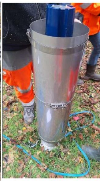
Pompe d'élévation 2 : renouvellement de la pompe et de la colonne montante
