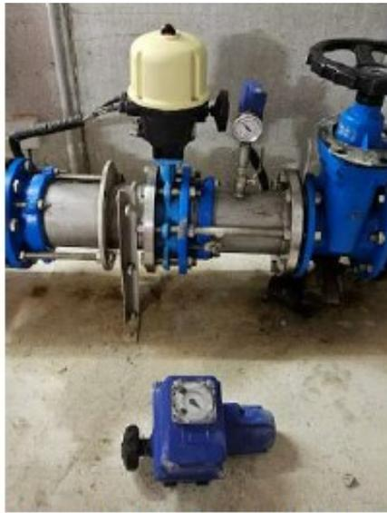
Renouvellement d'une vanne électrique
