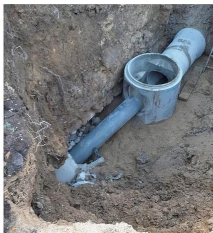
Formation d'une cavité par la détérioration du collecteur à Hautvillers
