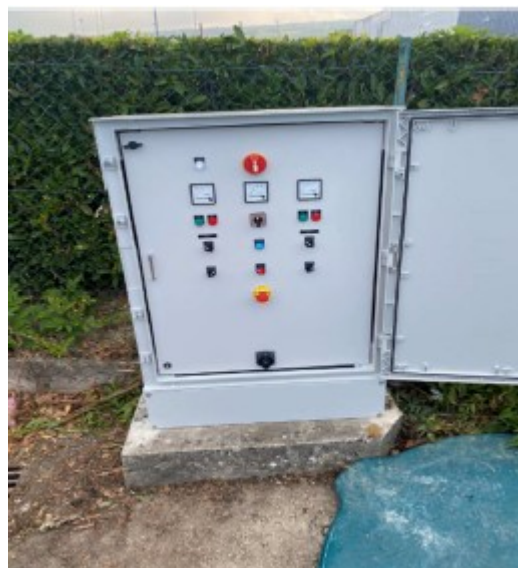
Exemple de renouvellement complet d'une armoire électrique : PR DIZY - Bas jardins
