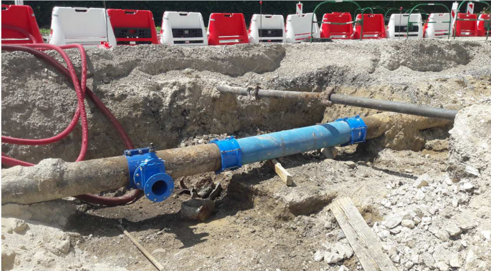
Raccordement et réparation d'une fuite dans le cadre des travaux de DIZY
